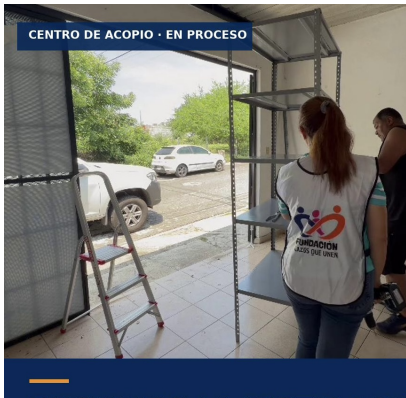
Preparacion del espacio
